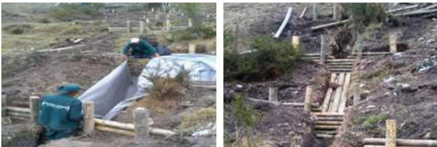
Figura 22. Construcción del filtro vivo en Cordillera Sur.
