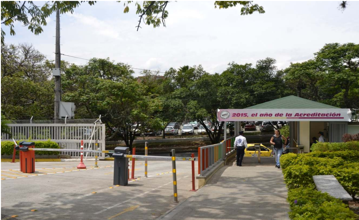
Foto: Portería principal en construcción. 2015 - $59.020.954
