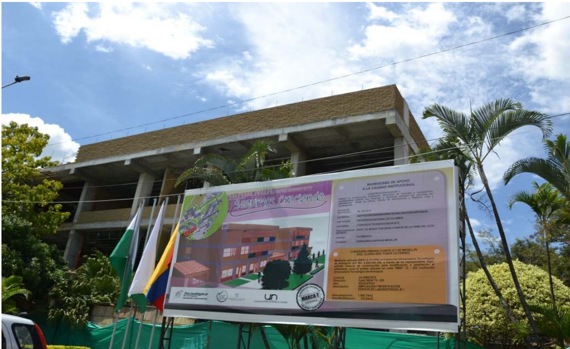
Foto: Edificio de laboratorios en construcción. 2015 - $3.373.894.020
